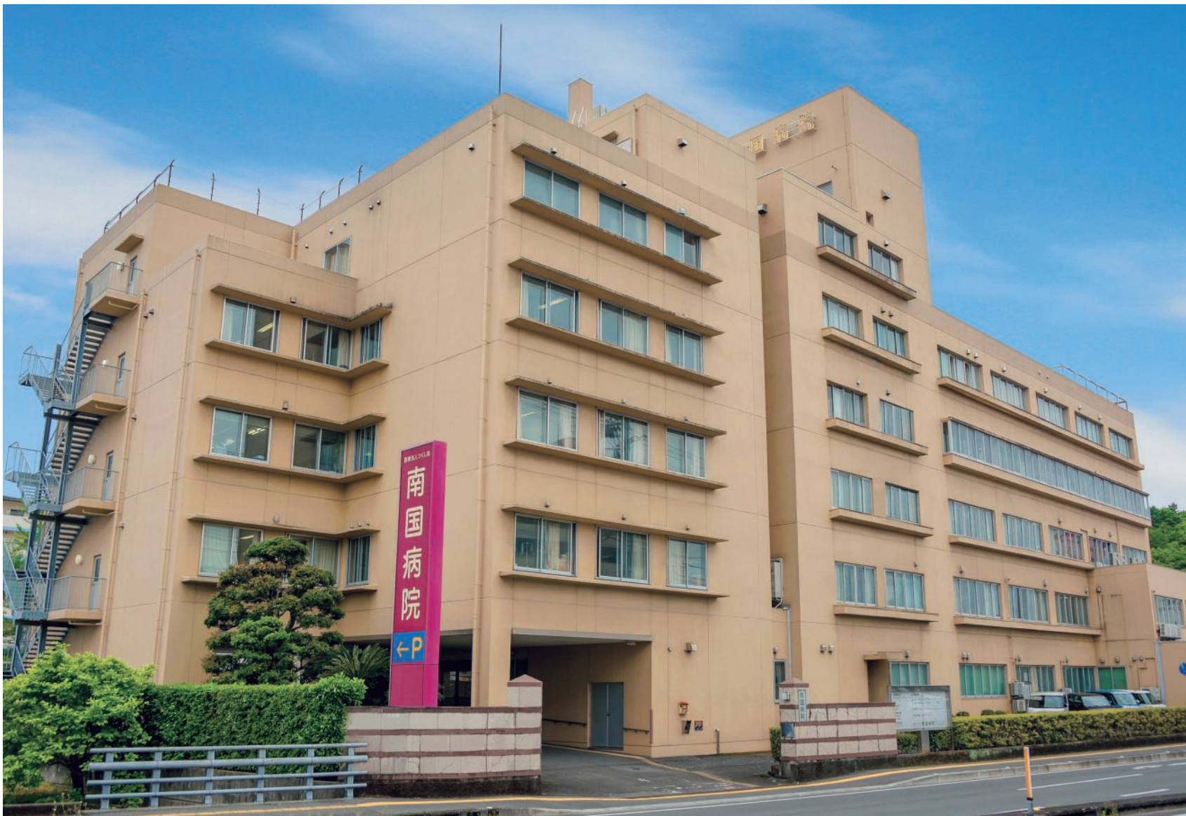
南国病院外観。現在の建屋は1978年に鉄筋コンクリート造り5階（一部6階）建て建設されたもので、現在162床が稼働中である。建築から40年以上が経過していることから、同院では10年後を目途に建て替えを検討しているという。
