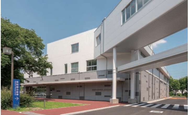
2024年1月、本館東側に新設オープンした放射線治療棟。鉄骨3階建てで、延べ床面積3129㎡。放射線治療室はリニアック更新時に運用台数を減らさないよう計5室を設置。最終的には旧施設の放射線治療装置更新に合わせて4台での運用を計画している。
