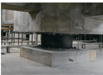
豊橋メイッククリニック地下の免震装置。耐震建築および免震構造を採用、非常用電源を設置して継続した透析医療を実現する環境を整備している。
