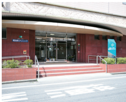
社会医療法人共愛会明治町クリニック外観。明治町エリアには、同クリニックをはじめ、外来クリニックとデイサービス、住宅型有料老人ホーム「サンセリテ明治町」、あやめ在宅ケアセンターを揃え、医療・介護サービスを提供している。
