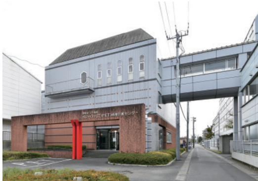
山王病院に隣接するPET画像診断センター。2台のPET-CTのほか、サイクロロンも設置しており、1日約16件のPET-CT検査を実施している。
