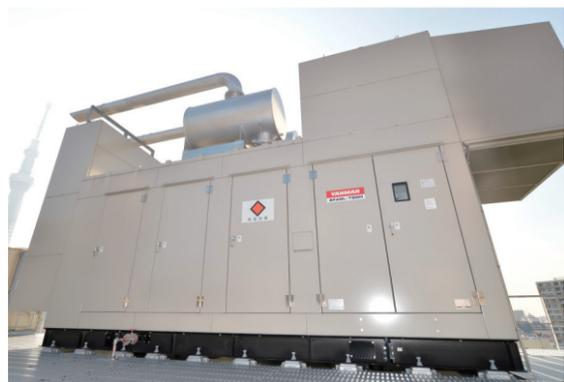
災害用の非常用電源装置。無給油でも2~4週間、病院の電源機能を維持できる。また、低地ゆえに、津波等、水害対策も兼ね、同施設は屋上に設置している
