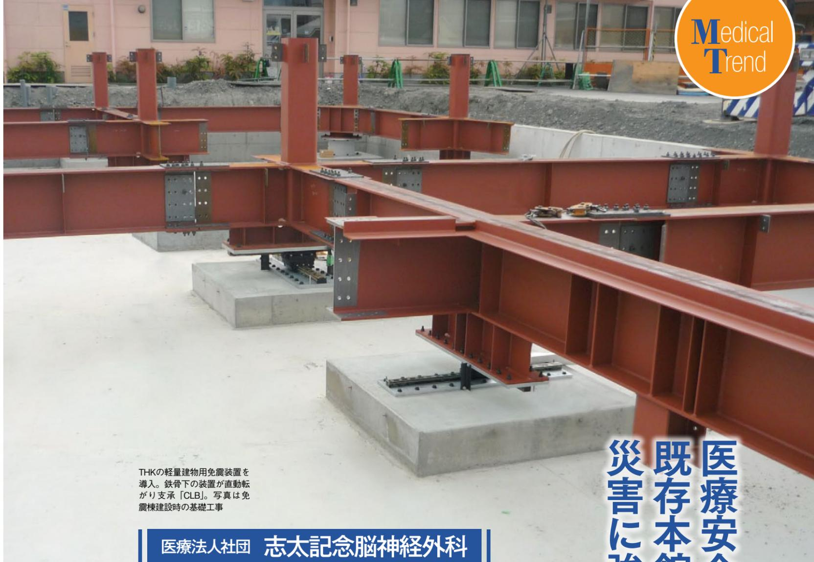
THKの軽量建物用免震装置を導入。鉄骨下の装置が直動転がり支承「CLB」。写真は免震棟建設時の基礎工事
