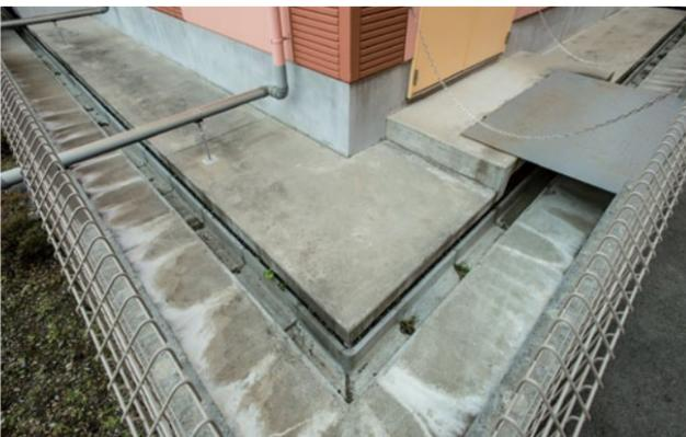
免震棟の免震クリアランス（可動域）は比較的ワイドな60cmに設定
