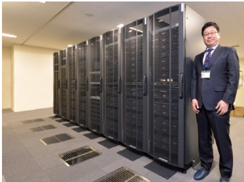
サーバ室内の様子。仮想化サーバ群の導入により、700床以上の大規模病院ながら、コンパクトなサーバ構成による省スペース化を実現している
