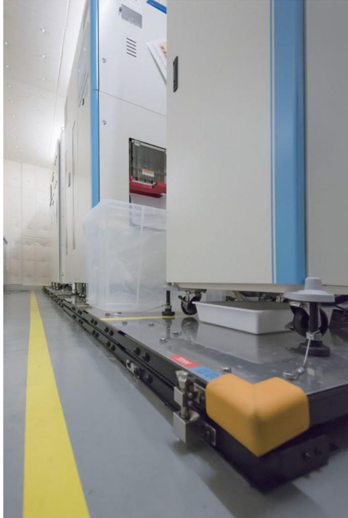
透析機械室にある大型装置の地震対策として、THKの部分免震装置「免震テーブルTSD」を導入。システム上に載せられている免震対象装置の転倒・破損を防止
