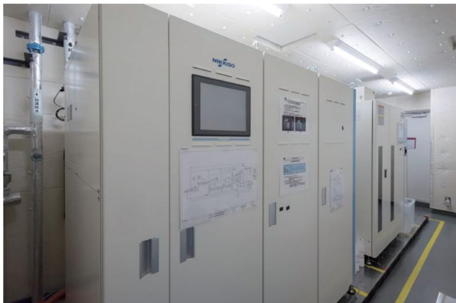
免震対象装置はRO装置、透析液供給装置、透析液溶解装置。同装置を横並びで免震テーブル上に設置
