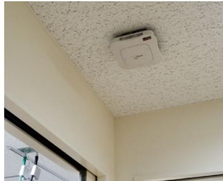
院内143ヵ所に無線LAN用アンテナを設置。モバイル端末やIoT機器の増設など、今後をにらんだネットワーク設計を実施している
