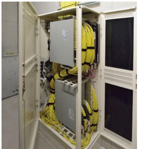
各階フロアに設置された光LANケーブル。同院では、全てのスイッチに対して光ケーブルを収容。スター型のトポロジーを構成しているが、スイッチの構成を変えれば他のトポロジーや通信経路を形成することもできる。耐障害性、拡張性の高いネットワーク構成になっている
