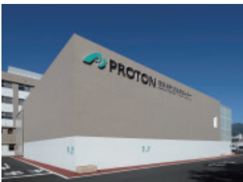
陽子線治療センター外観。それまで駐車場だったスペースを利用して、20m 四方程度の敷地内に世界初となる上下配置式小型陽子線治療装置を設置、2014 年 9 月より診療を開始した
