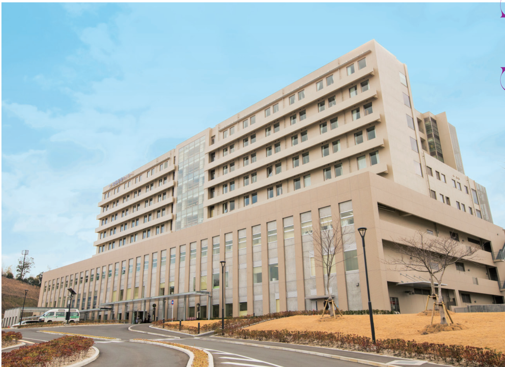
岩国医療センターの建物は地上11階建て、延べ床面積は約4万平方メートル。免震構造を採用するなど、災害時にも中核病院としての機能を果たせるように万全の体制を整えている
