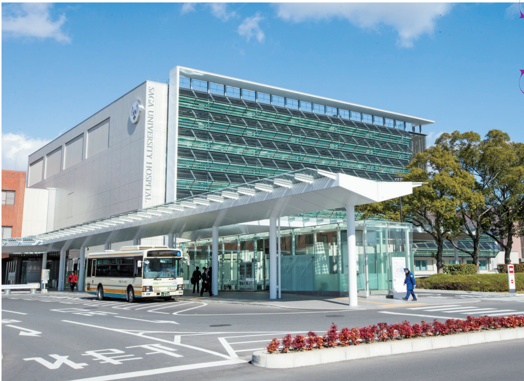
佐賀大学医学部附属病院では、附属病院再開発プロジェクトが推進中。2014年1月には、救命救急センターを中心とした南新棟（写真）と、療養病棟の北新棟がオープン。HIS更新と併せ、病院機能および医療の質の向上を図っている
