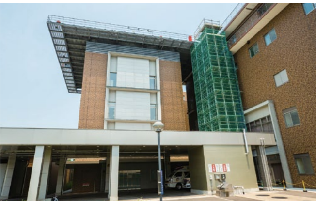
2012年に免震棟として建設された救命救急センター棟
