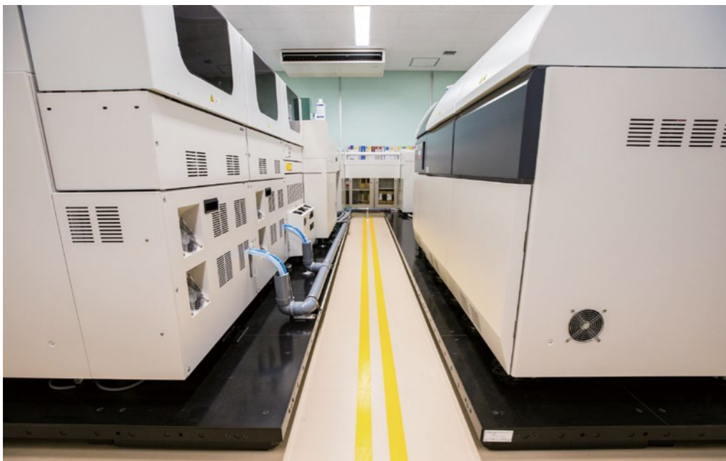
今後は生化学・免疫検査機器（写真）と連動する検査機器の免震化を計画
