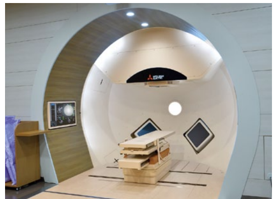
陽子線照射室。現在はプロトビームによる照射のみだが、2017年中にスポットスキニング照射を開始する予定である
