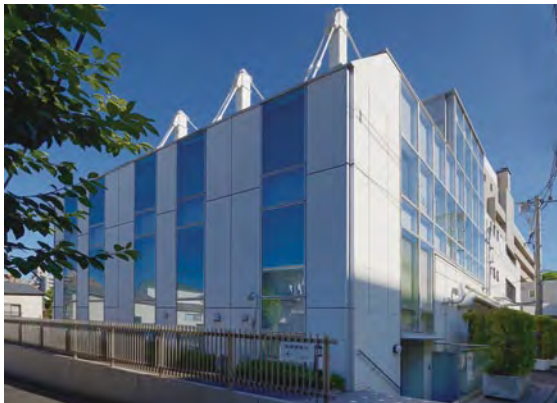
情報棟 1 屋上の3つの突起は建物耐震対策の設備
