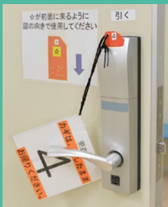
パーテーションア用カードロック「Sherlock III MASTER」。既設のパーテーション扉に簡単に取り付けことができ、特別な加工も不要。鍵紛失時も内蔵カードキーを容易に交換でき、スピーディーな対応が可能
